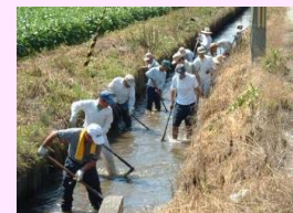
水路の泥上げ
