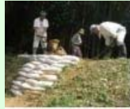
漏水箇所の補修
