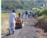
未舗装農道の舗装
