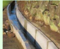
コンクリート水路の更新
