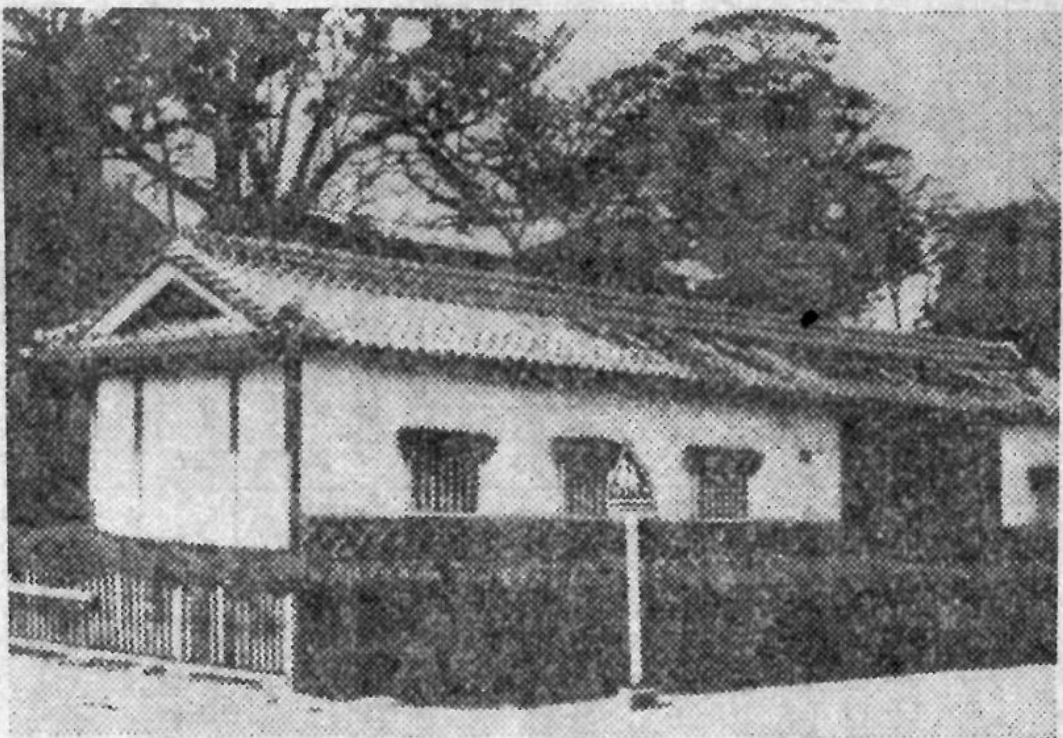
福岡市にある旧母里太兵衛邸の長屋門
