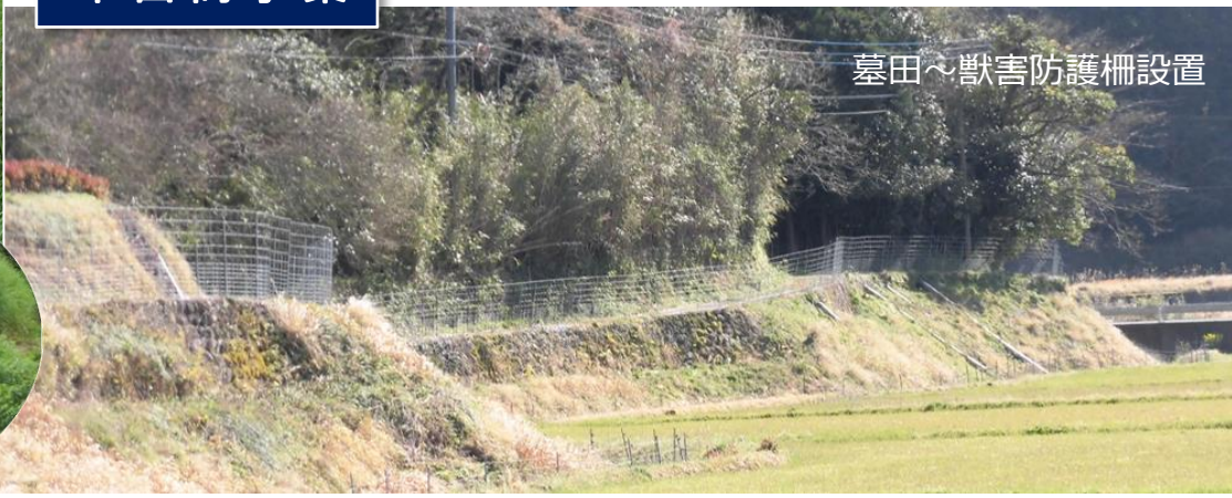
7/24 獣害防護柵作業
