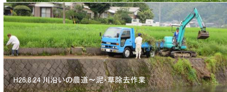
H26.6.29 水路・農道・ため池の点検
